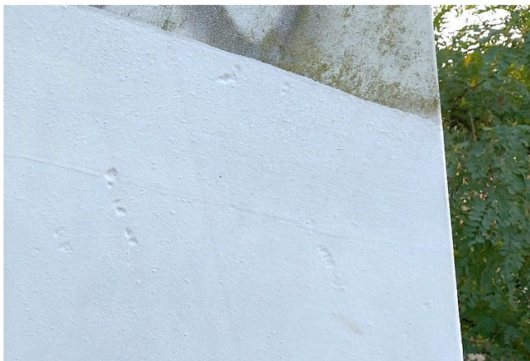
Obr. 35 K01 - Pravý hlavní nosník Vrpy na plechu mezilehlé diagonály (typická porucha).
