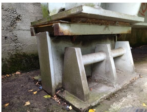
Obr. 61 Ložisko K01-O01-P: pohled proti směru staničení
