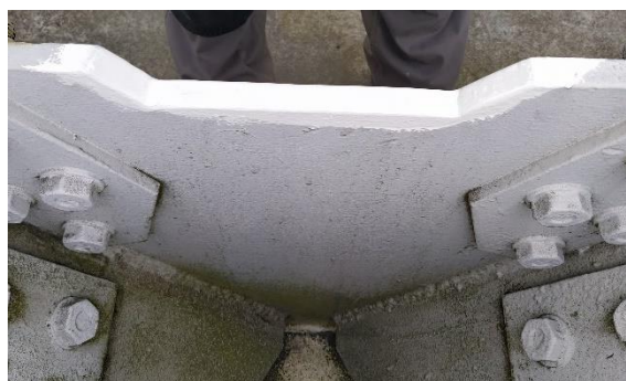
Obr. 191 Místo odběru vzorku po aplikaci protikorozního nátěru
