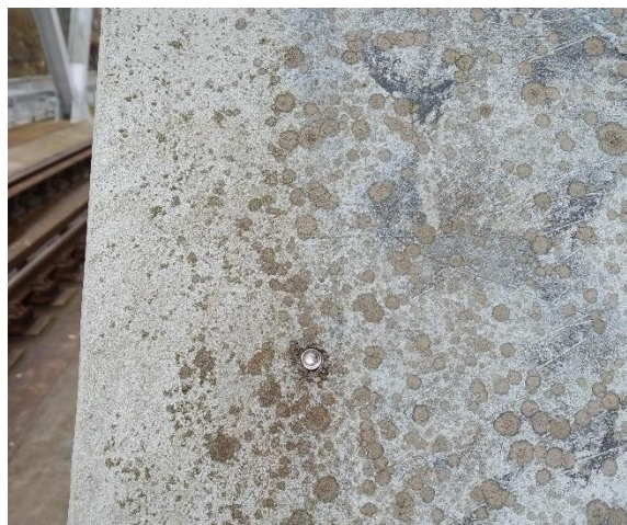
Obr. 223 Otvor na horním lici koncové diagonály pravého hlavního nosníku K01 zapravený nerezovým stavěcím šroubem následně natřeným opravnou nátěrovou hmotou
