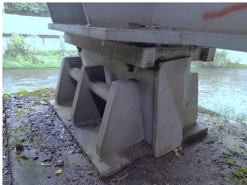
Obr. 59 Ložisko K01-O01-L: pohled ve směru staničení
