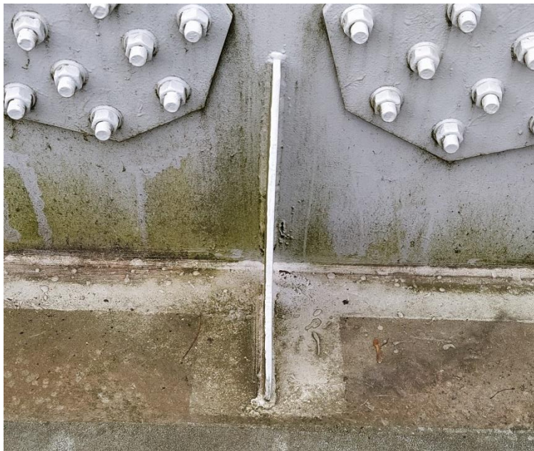
Obr. 34 K01 - Pravý hlavní nosník Plastická deformace koutové výztuhy.
