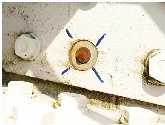
Obr. 208 Porušený šroub K02 – D16P
