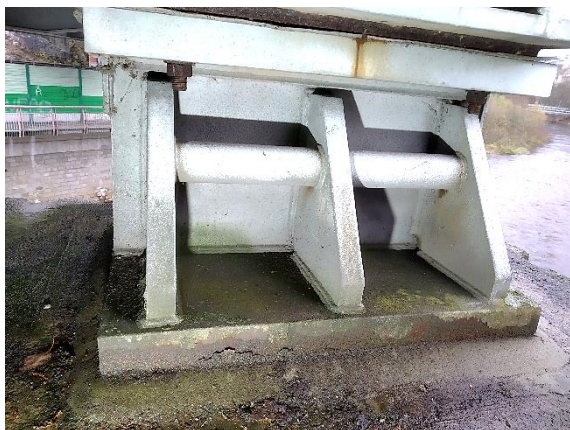
Obr. 69 Ložisko K02-P01-P: pohled ve směru staničení
