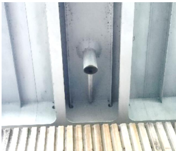
Obr. 162 Odvodňovač K02 u pilíře P01 – pohled zdola
