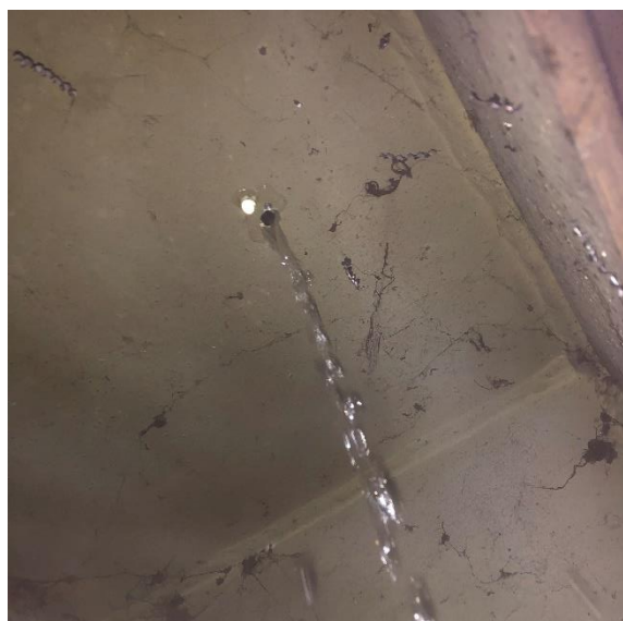
Obr. 221 Voda odtékající z konce levého nosníku K02
