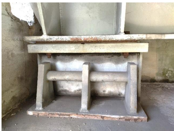
Obr. 71 Ložisko K02-O02-L: pohled ve směru staničení
