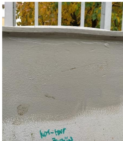
Obr. 210 Oprava trhliny na začátku pravého hlavního nosníku (foceno dne 2.11.2023)
