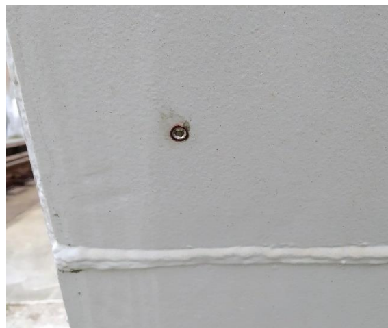
Obr. 224 Otvor na dolním lici koncové diagonály levého nosníku K02 zapravený nerezovým stavěcím šroubem následně natřeným opravnou nátěrovou hmotou
