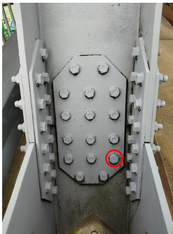
Obr. 204 Vyměněný šroub K02 – D3L
