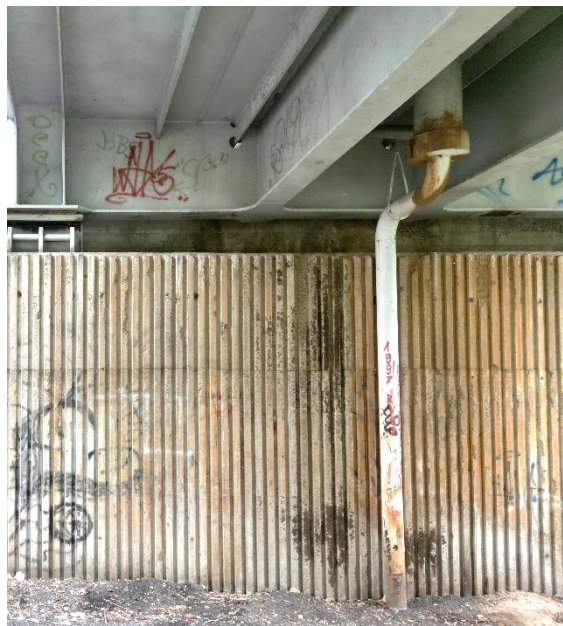
Obr. 160 Odvodnění K01 u opěry O01 – pohled zdola
