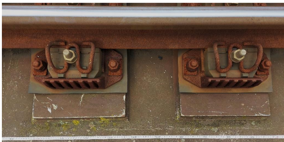
Obr. 196 Kontrola osové vzdálenosti upevňovadel
