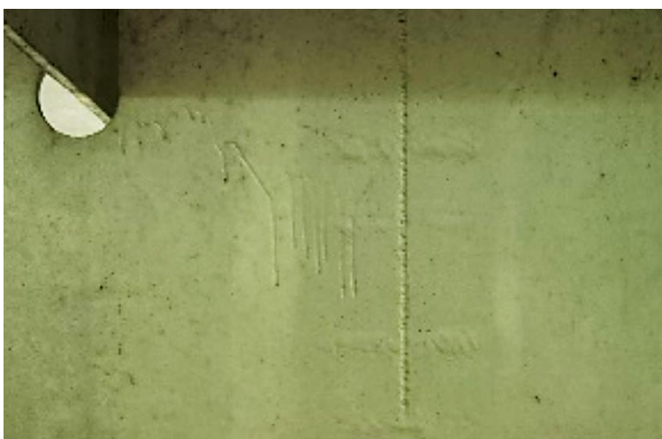
Obr. 174 Konstrukce K01 Stečeniny (typická vada)
