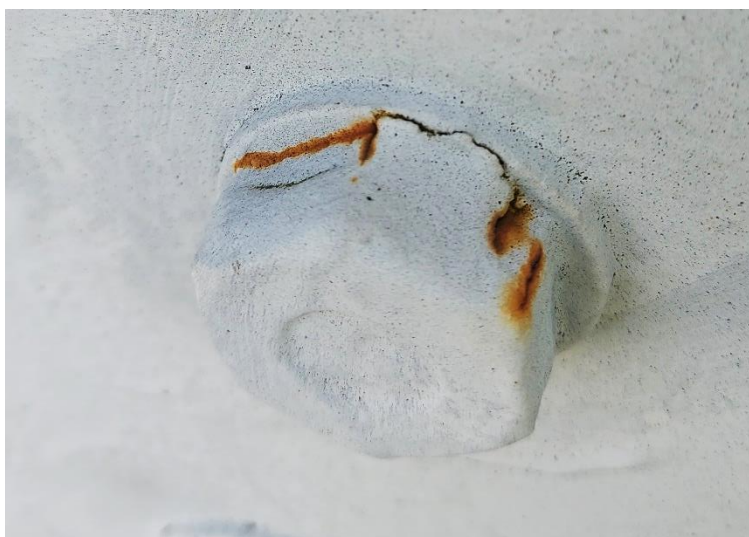
Obr. 173 Konstrukce K01 Popraskaný nátěr na šroubech a počínající koroze (typická porucha).
