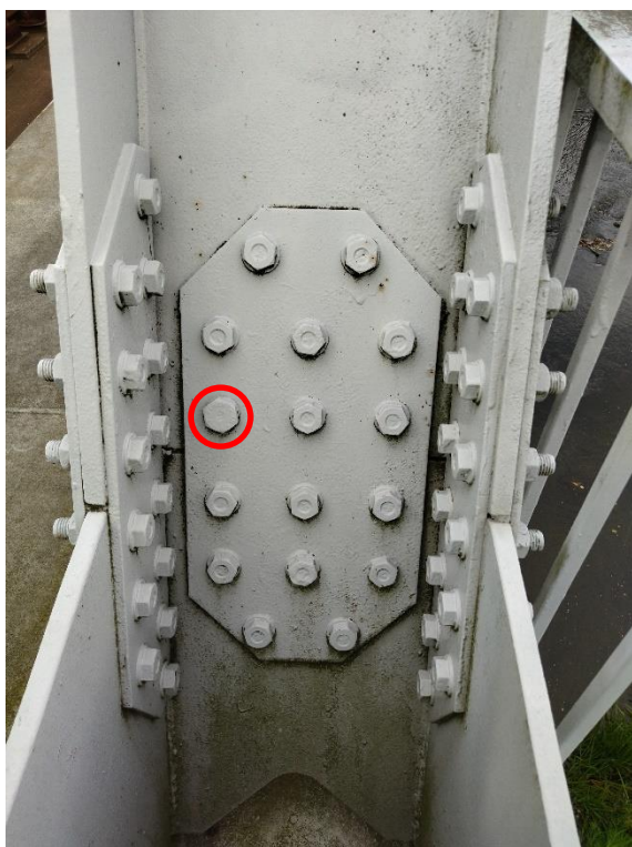
Obr. 203 Vyměněný šroub K01 – D13P
