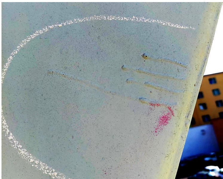
Obr. 172 Konstrukce K01 Stečeniny (typická vada).
