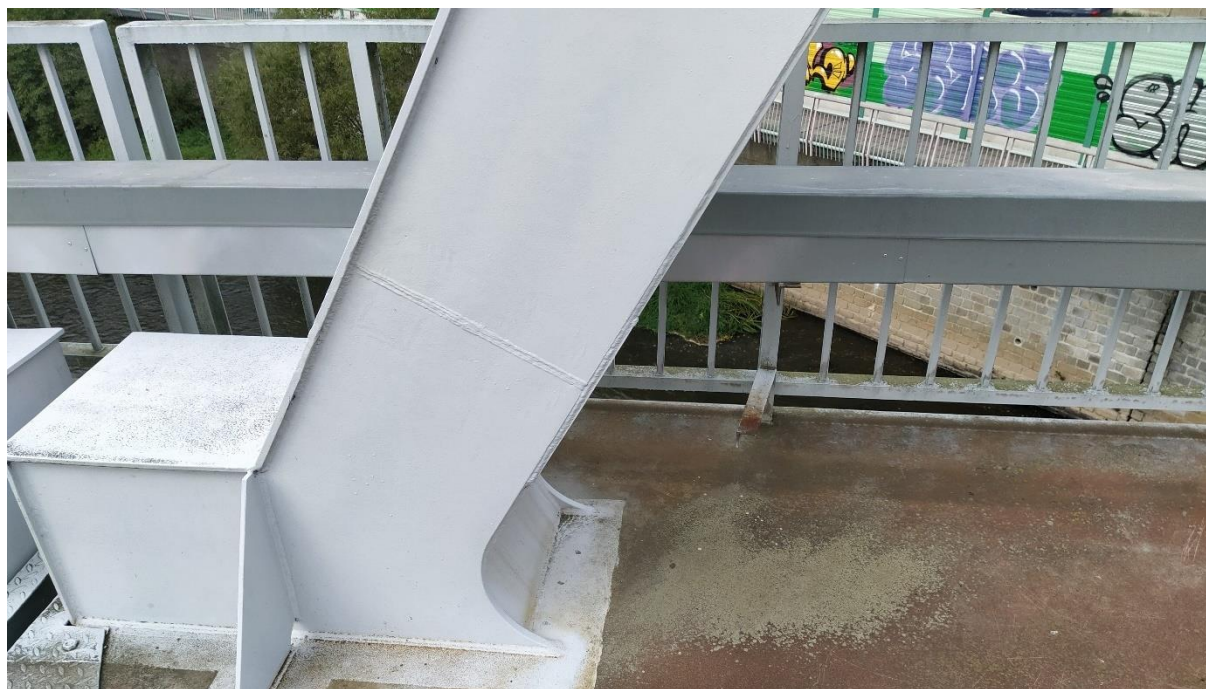
Obr. 153 Pohled na kabelový žlab umístění na konzolách na levém zábradlí
