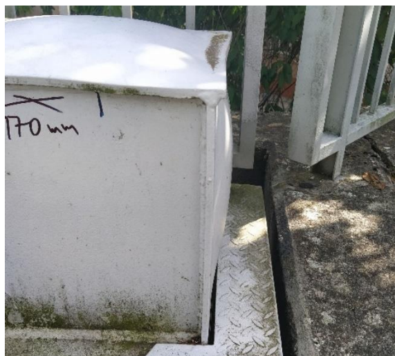
Obr. 211 Vyboulení plechů na začátku pravého hlavního nosníku K01 nad opěrou O01
