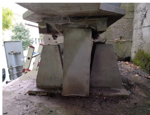
Obr. 62 Ložisko K01-O01-P: pohled zleva
