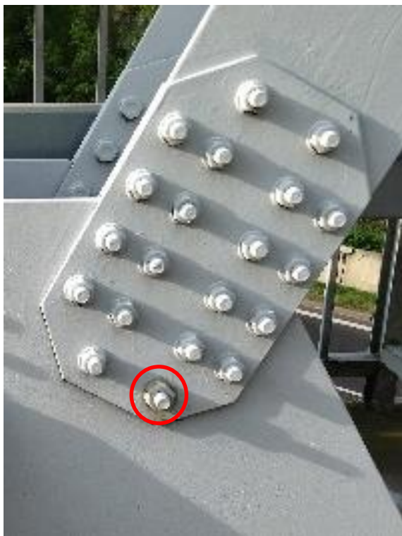
Obr. 205 Vyměněný šroub K02 – D9L
