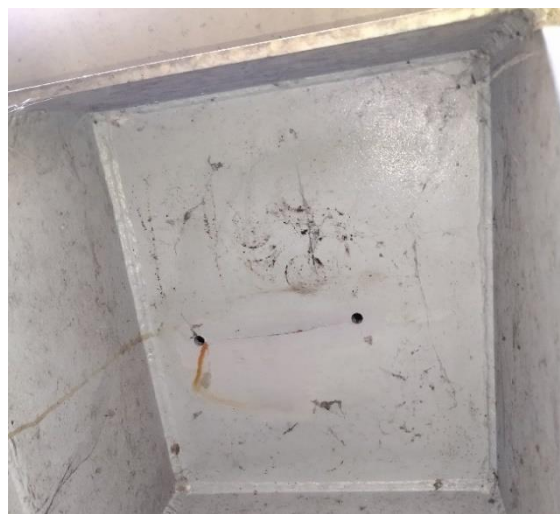
Obr. 212 Odvrtaná trhlina v desce mostovky pod vyboulenou částí na začátku pravého hlavního nosníku
