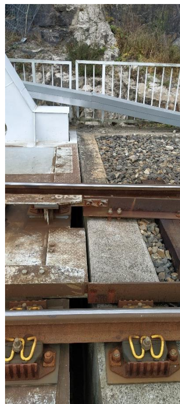
Obr. 85 Překrytí spáry mezi K02 a O02
