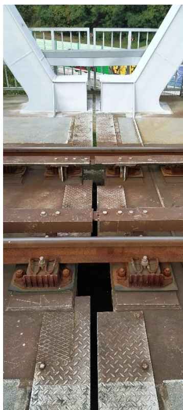
Obr. 84 Překrytí spáry mezi K01 a K02
