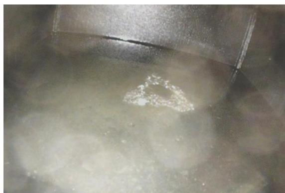
Obr. 228 Stojatá voda v dolní části diagonály na začátku levého hlavního nosníku K02
