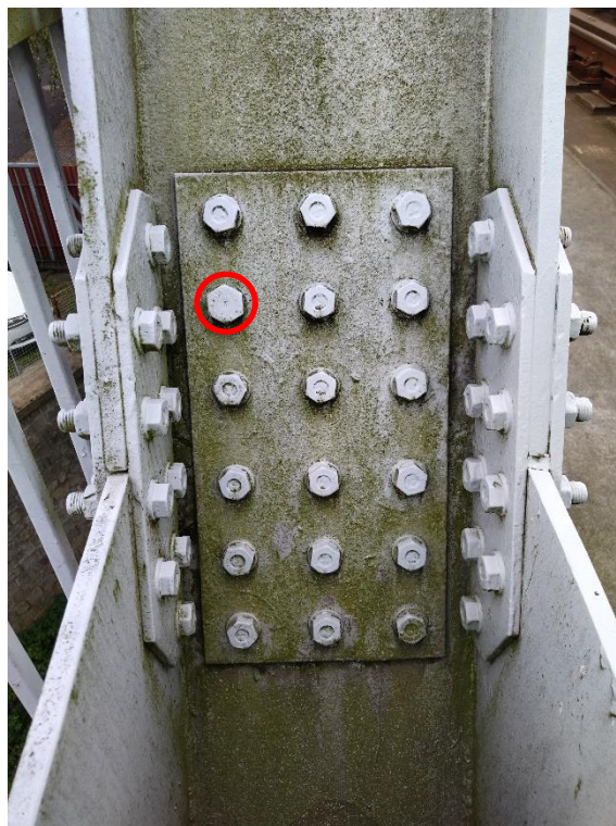
Obr. 202 Vyměněný šroub K01 – D10P
