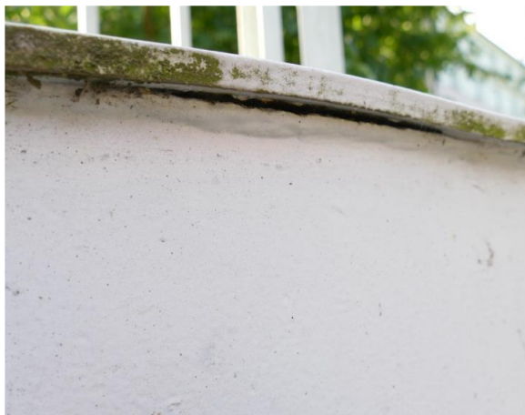
Obr. 209 Trhlina na začátku pravého hlavního nosníku K01 nad opěrou O01 [11]
