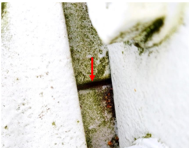
Obr. 36 K01 - Pravý hlavní nosník Nezatmelená spára, kde může vznikat časem štěrbínová koroze (typická vada).
