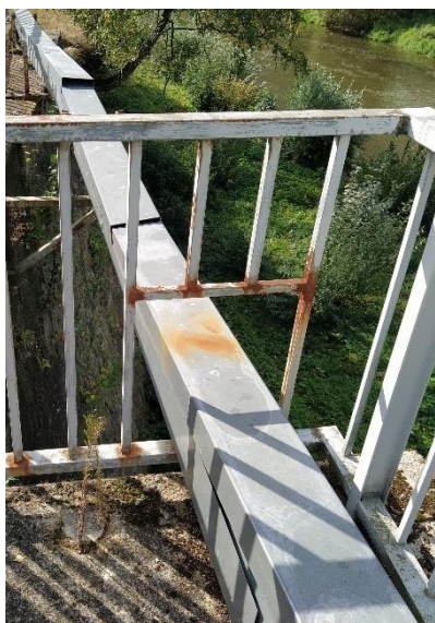
Obr. 150 Pohled na kabelový žlab před K01
