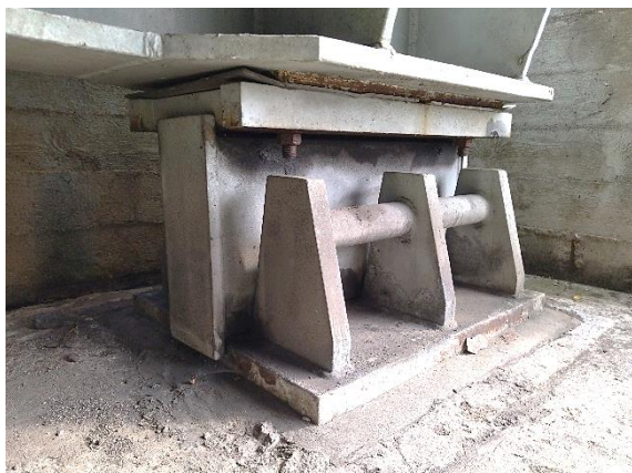
Obr. 73 Ložisko K02-O02-P: pohled ve směru staničení
