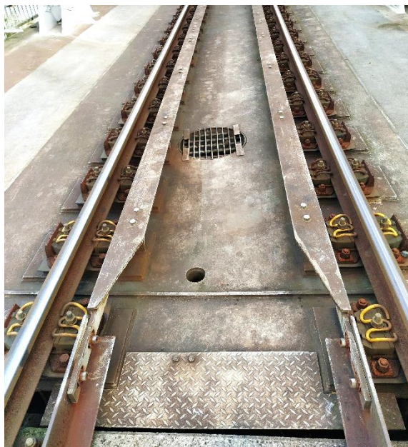
Obr. 159 Odvodňovač K01 u opěry O01 – pohled shora
