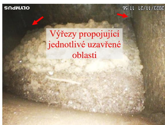
Obr. 226 Usazeniny v dolní části koncové diagonály na začátku pravého nosníku K01
